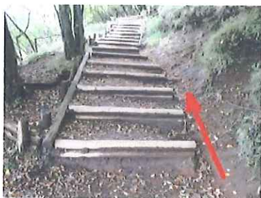
補修前： 丸太二段重ねで段差が大きく登山者は右脇を歩いている
